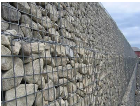
Figur 4: Eksempel på gabion med tætliggende sten
