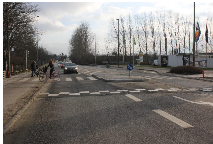
Figur 15: Den nyetablerede krydsningshelle på Vestbuen. Krydsningshellen er udført sammen med et fodgængerfelt, en hævet flade samt dynamisk skiltning af hastigheden.
