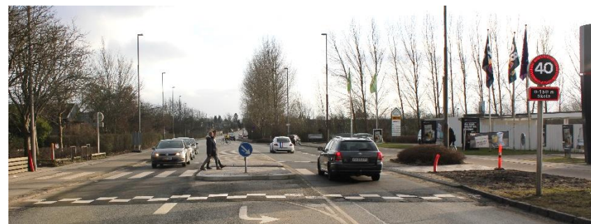
Figur 17: Der er i 2014 etableret en hævet flade på Vestbuen ved tankstationen. I 2015 vil der ligeledes blive opsat et Toronto-anlæg, der gør bilisterne opmærksomme på krydsende fodgængere.
