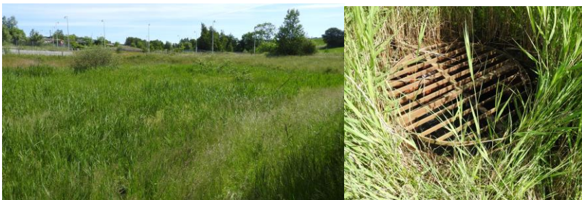
Figur Beskyttede arter-38 Regnvandsbassin med brønd syd for Kildedal st.
