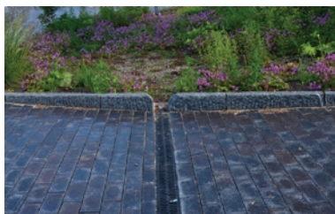
Regnbed – afledning af regnvand
