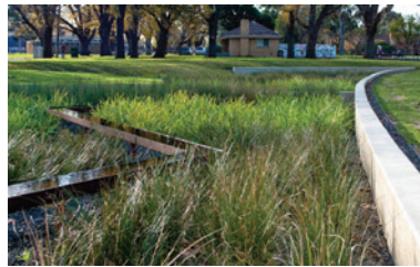
Regnvand i rende og grøft
