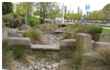
Forsinkelse og nedsivning af regnvand
