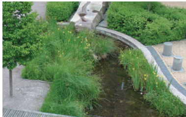
Regnvand afledes via rende til bassin i gård
