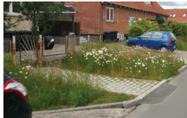
Regnbed – nedsivning af regnvand fra p-plads
