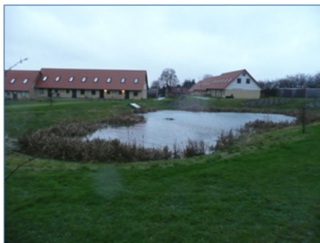
Figur 2 Et vådt regnvandsbassin i Århus udført uden sektionsoptdeling
