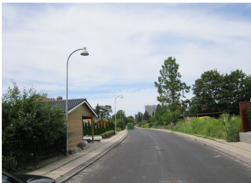
Ensidet mastplacering. Masterne er placeret vinkelret på vejen og understreger vejens forløb.
