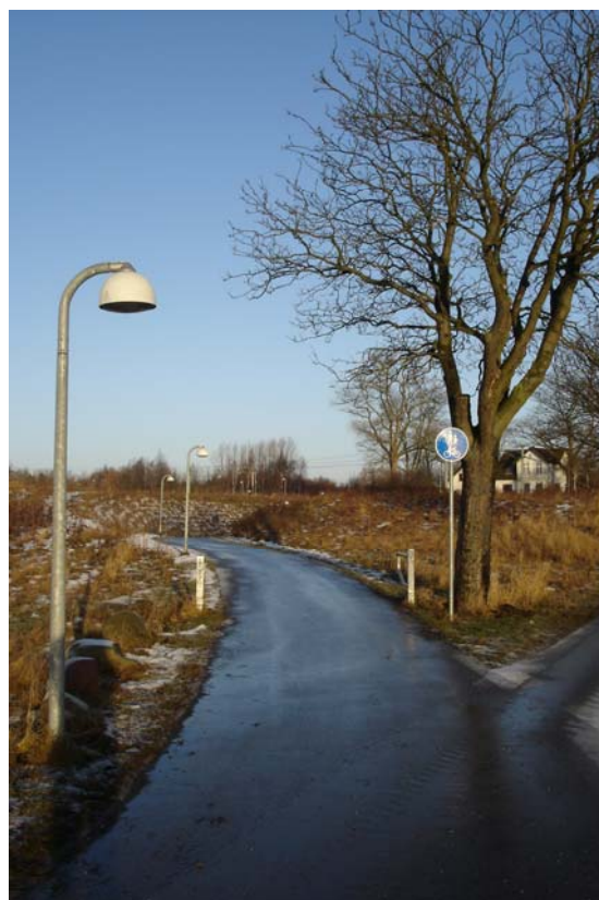
Eksisterende belysningsanlæg med københavnerarmatur på kortere mast langs banen ved Pederstrup.
