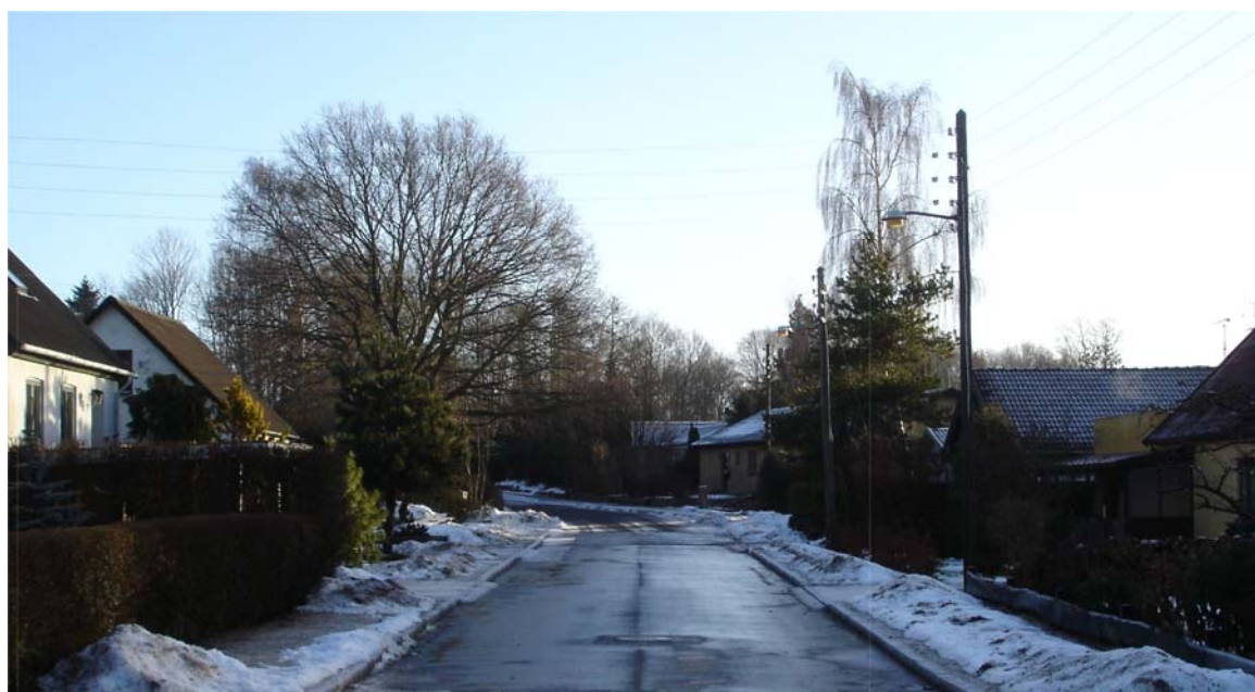
Eksisterende belysningsanlæg med byhat.
