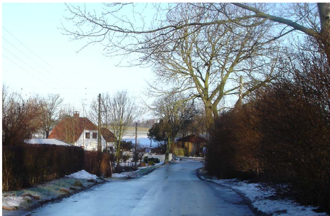
Eksisterende belysningsanlæg med byhat monteret på træmast.
