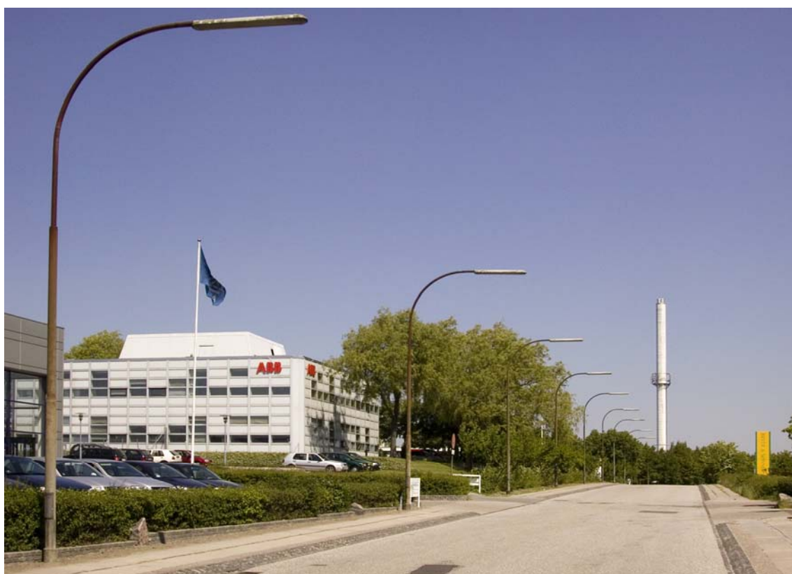
Eksisterende belysningsanlæg med lysstofrør.
