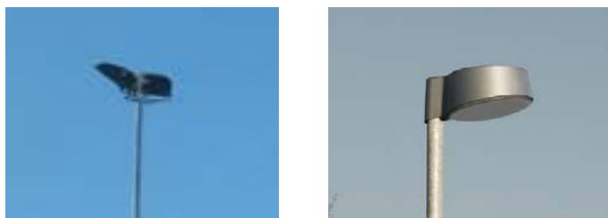
Eksempel på armatur med en lysåbning der er vendt skråt opad og et armatur med nedadrettet lysåbning.
