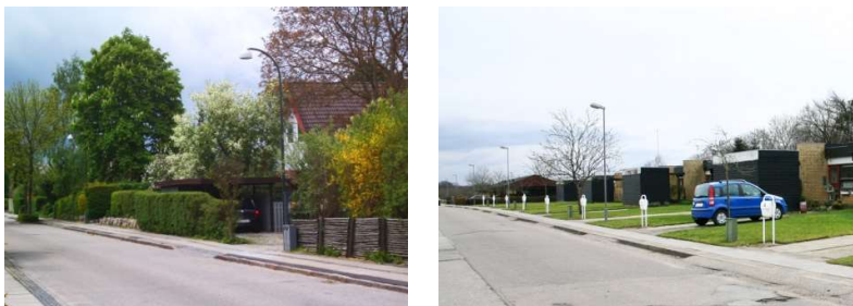
Forskellig armatur og mastearm i to boligområder. Belysningsalæggene understreger i begge tilfælde områdets arkitektur og bidrager også til at skabe differentiering områderne imellem.
