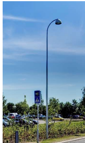
Eksempel på armatur med en lysåbning der er vendt skråt opad og et armatur med nedadrettet lysåbning.
