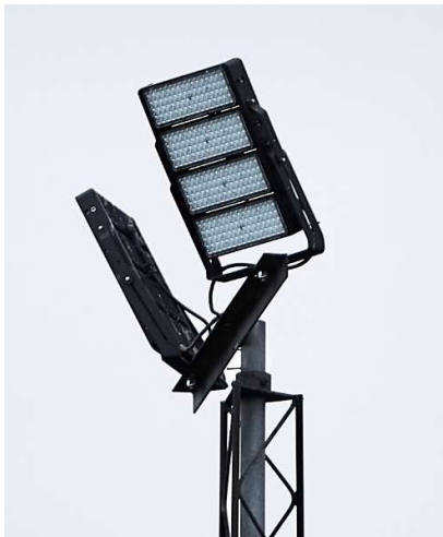
Eksempel på armatur med en lysåbning der er vendt skråt opad og et armatur med nedadrettet lysåbning.
