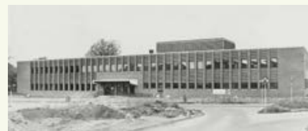
Det nybyggede posthus på Banegårdspladsen, 1977.
