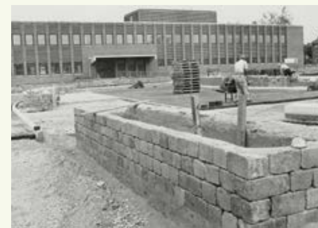
Banegårdspladsen under anlæggelse, 1977.
