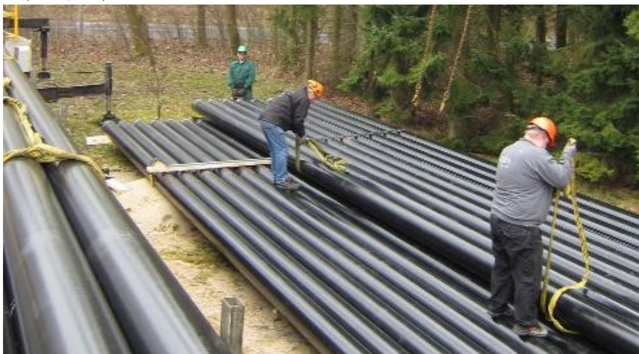
Figur 2.6 Håndtering af rør på rørlagerpladsplads
