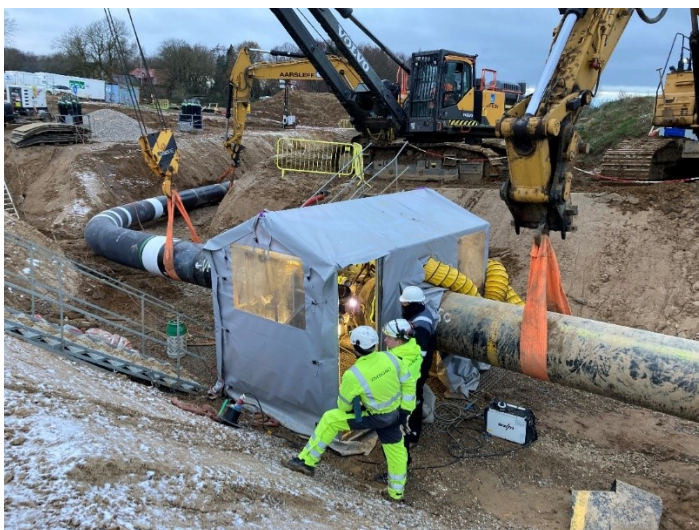
Figur 4.1 Eksempel på tilkobling af ny rørledning (venstre side) til eksisterende rørledning (højre side). Eksisterende ledning er tømt for gas.
