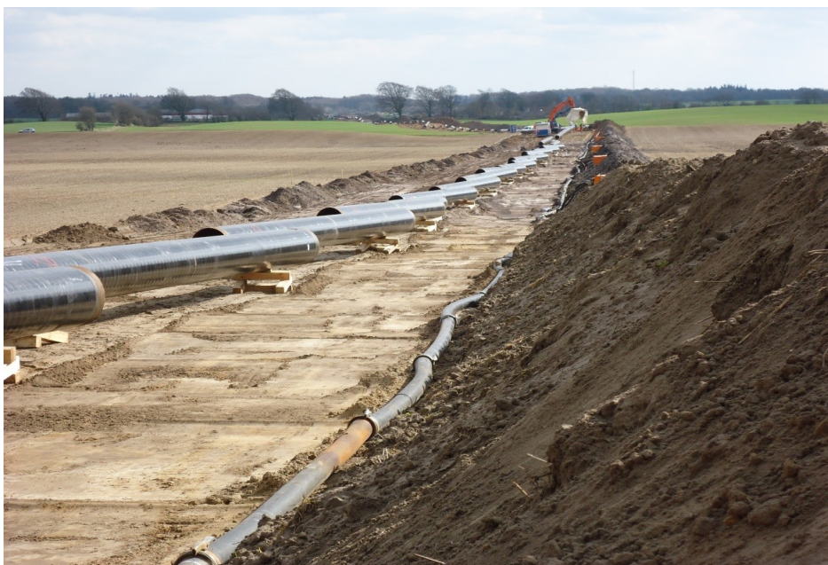
Figur 2.1 Rør udlagt i ryddet arbejdsbælte
