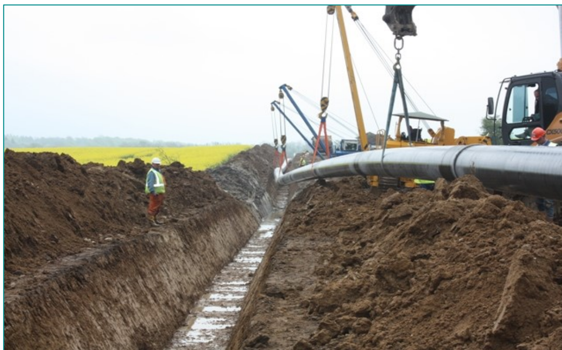
Figur 2.2 Nedlægning af gasledning i ledningsgrav
