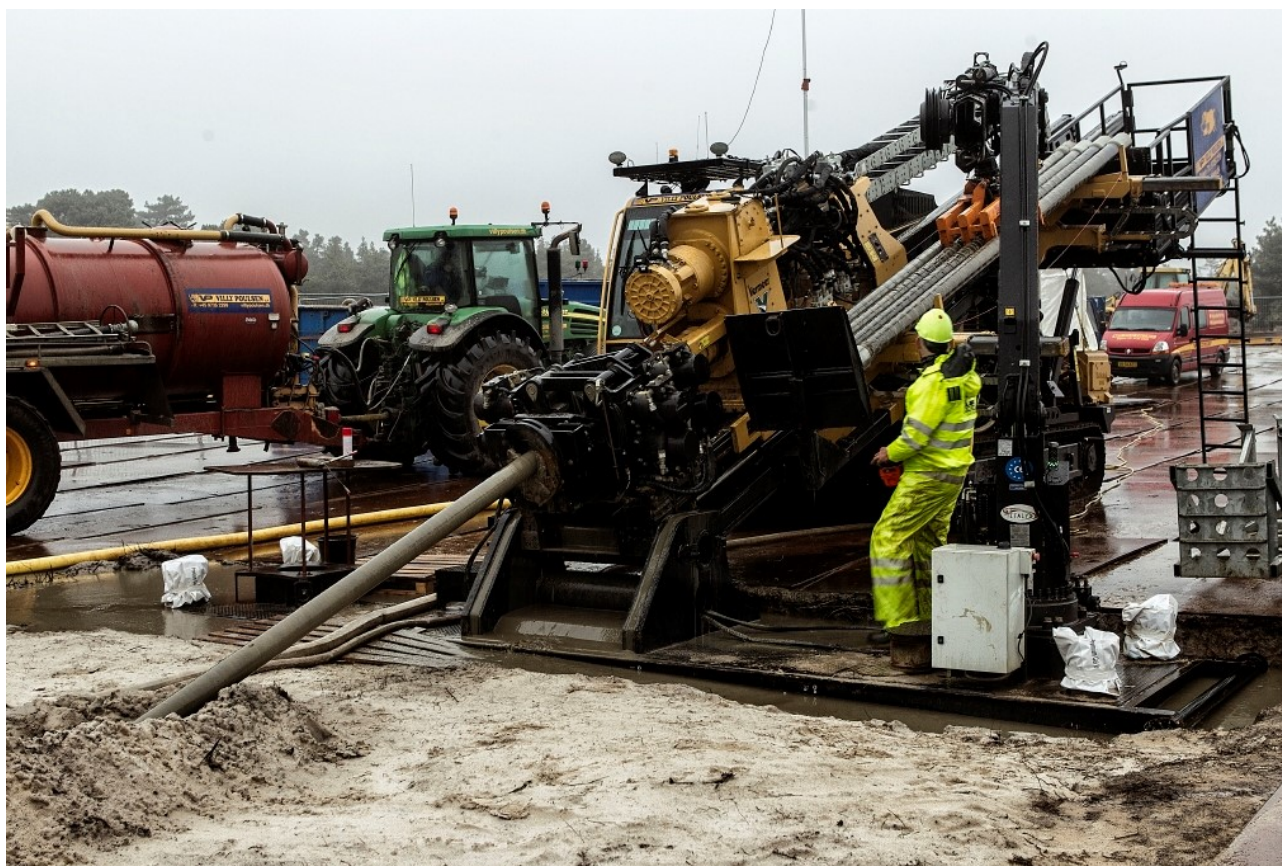
Figur 3.2 Eksempel på arbejdsareal ved styret underboring.
