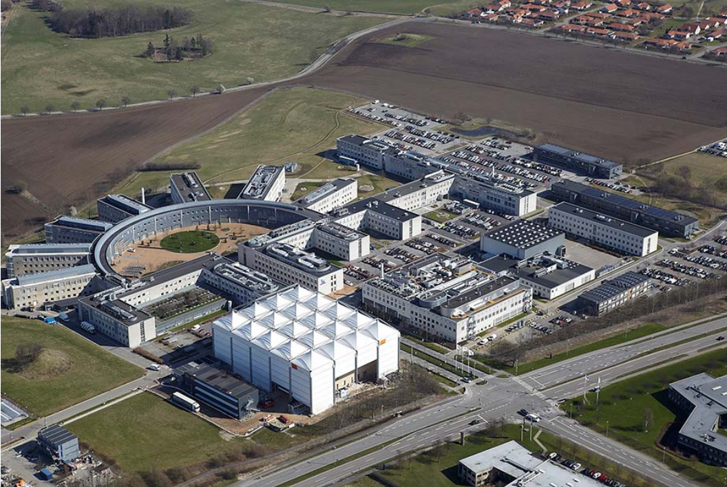
Ny produktionsbygning under opførelse vest for hovedadgangen ad Novo Nordisk Park
