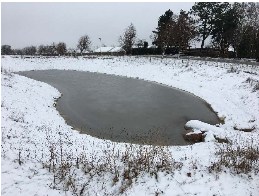
Nyt regnvandsbassin ved Jungshøjvej
