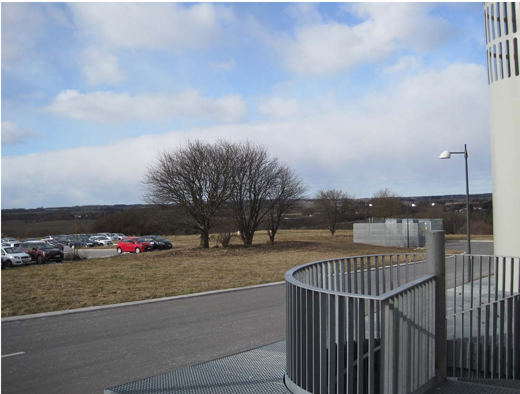
Udsigt mod nordvest ved den vestlige bygning
