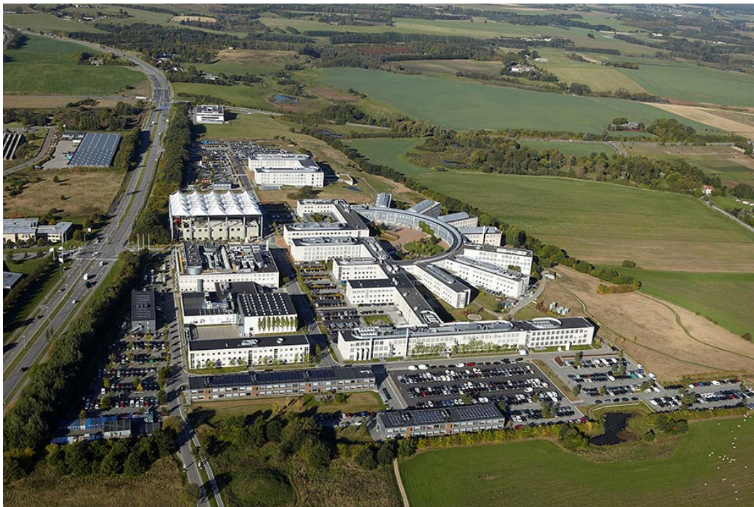
Lokalplanområdet set fra øst med Hyldhøj, midlertidige bygninger og 'paddesø' i forgrunden
