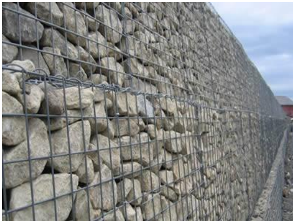
Figur 4: Eksempel på gabion med tætliggende sten
