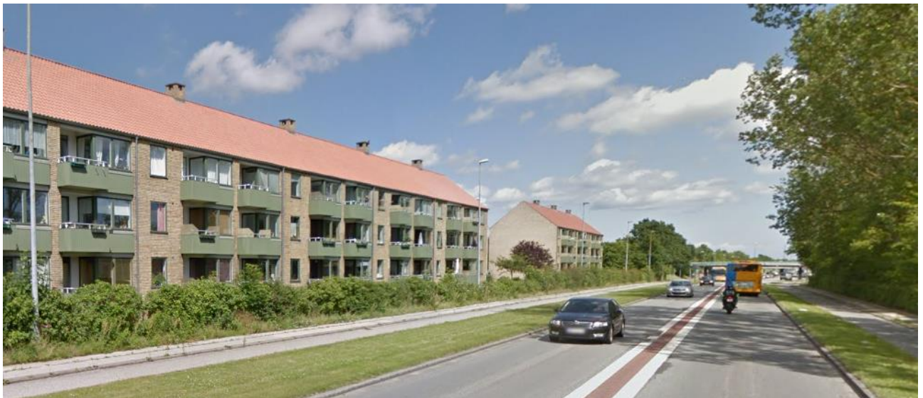
Figur 5: Bebyggelsen på den nordlige side strækningen er etageboliger og placeret tæt på den trafikerede vej
