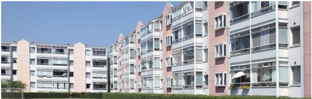
Ellebo som det så ud efter facaderenoveringen i 1991 med de tidstypiske pastelfarver.
