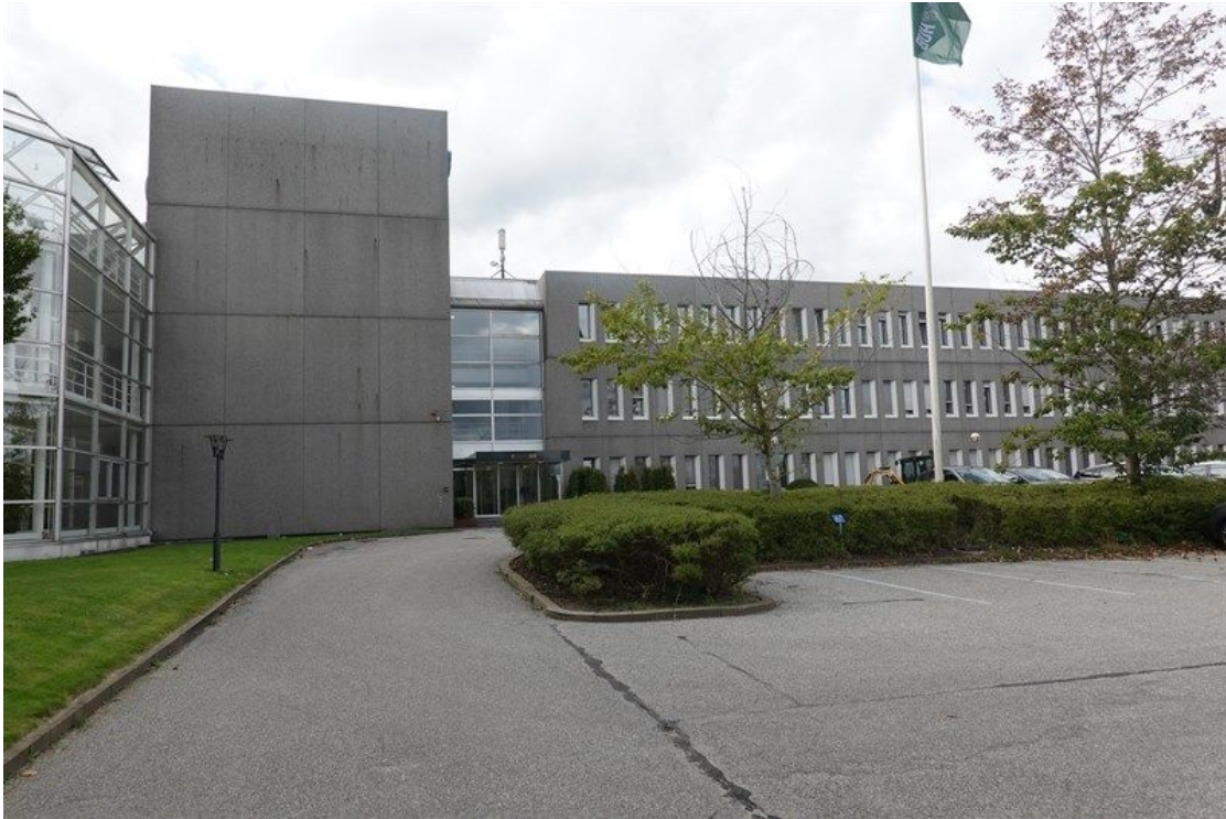
Den eksisterende kontorbygning.
