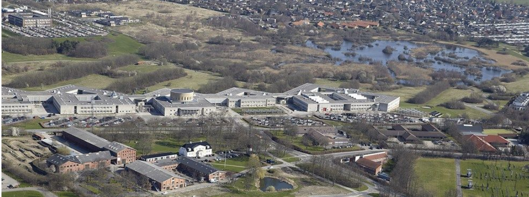
Universitetsbygningen med *Lautrupgaard' i forgrunden, Tryg i baggrunden, 'Madpakkehuset' midt i billedet og Sømosen øverst til højre (c) JWLuftfoto
