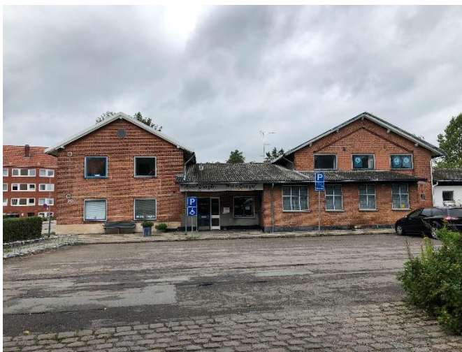
Eksisterende erhvervs- og lagerbygninger som forudsættes nedrevet.
