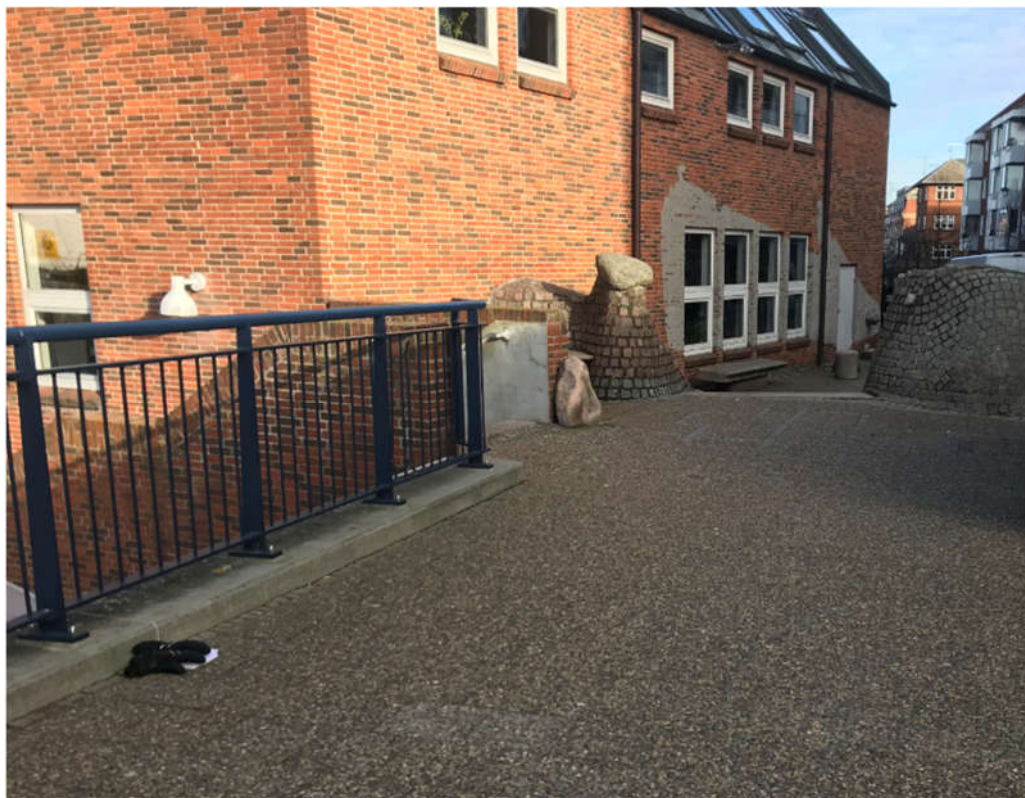
Figur A-6 - Trappenedgang og rækværk ved Centrumgaden nord for banen
