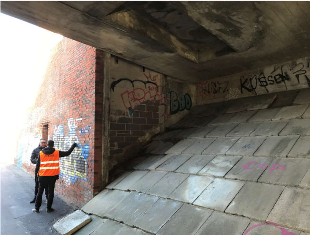
Figur A-4 - Område for elevatorplacering ved Centrumgaden, nord for banen (set mod vest)
