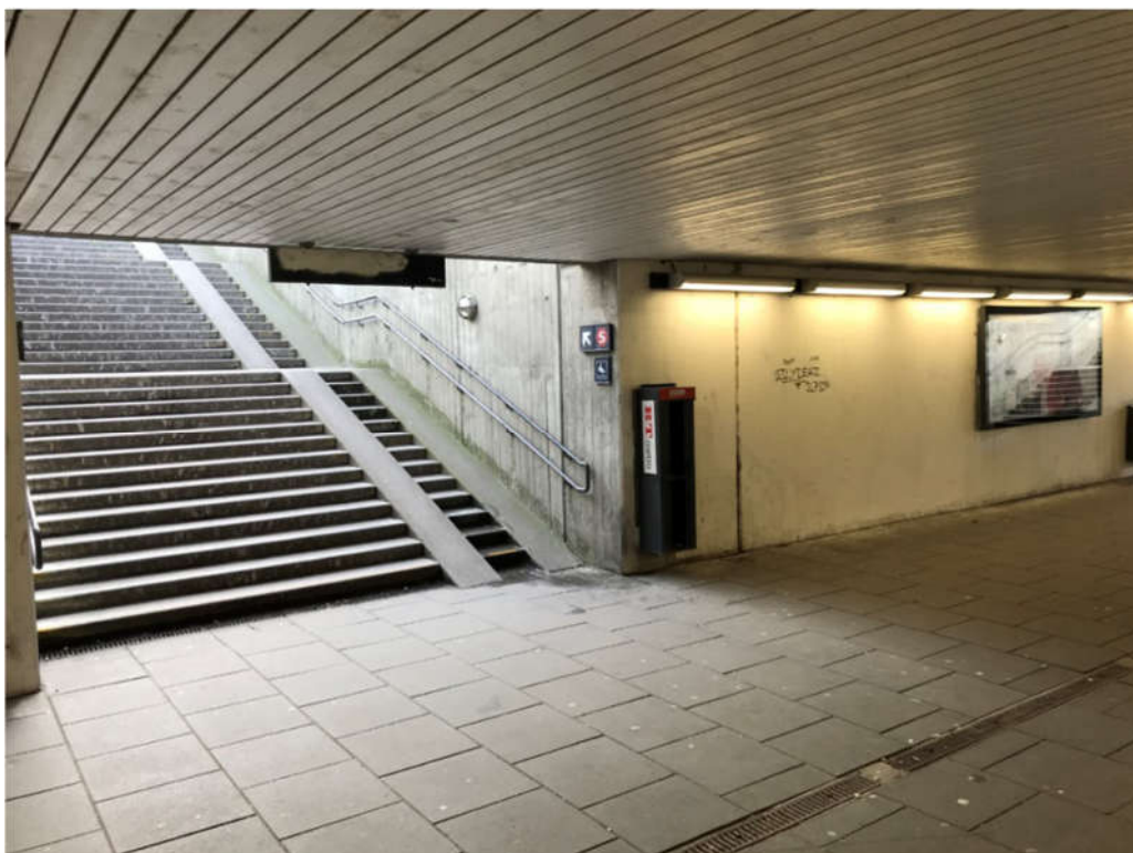
Figur A-10 – Trappenedgang fra perron i den vestlige perrontunnel (set mod øst, placering af elevator tænkt i modsæt side)
