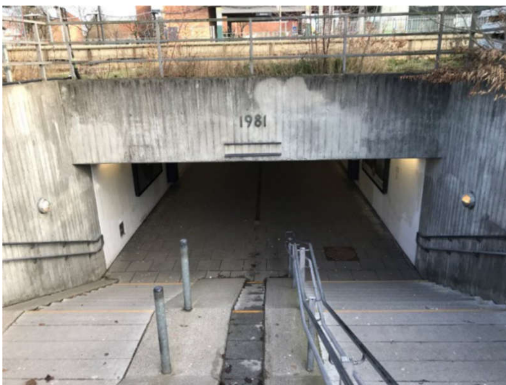
Figur A-11 – Sydlig trappenedgang i den vestlige perrontunnel (set mod nord)
