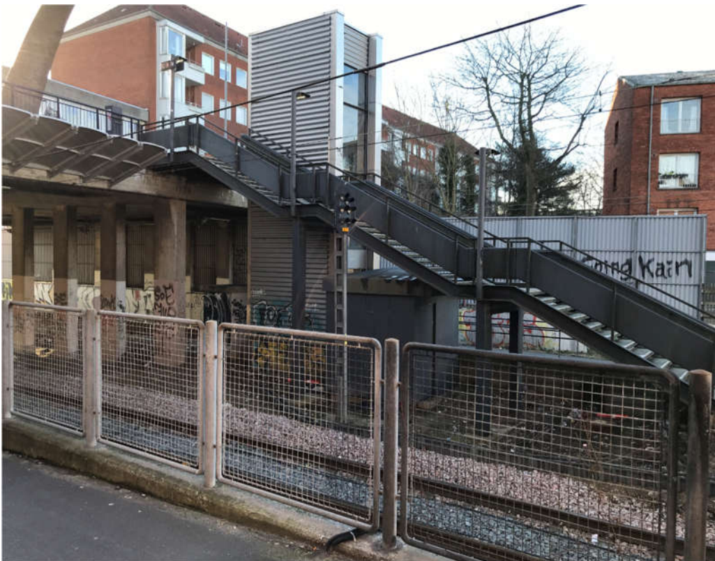
Figur A-2 - Eksisterende DSB-elevator ved Centrumgaden
