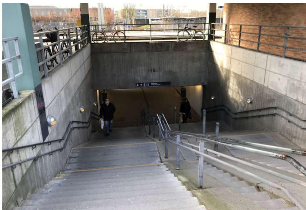
Figur A-6 – Nordlig trappenedgang i den vestlige perrontunnel (set mod syd)
