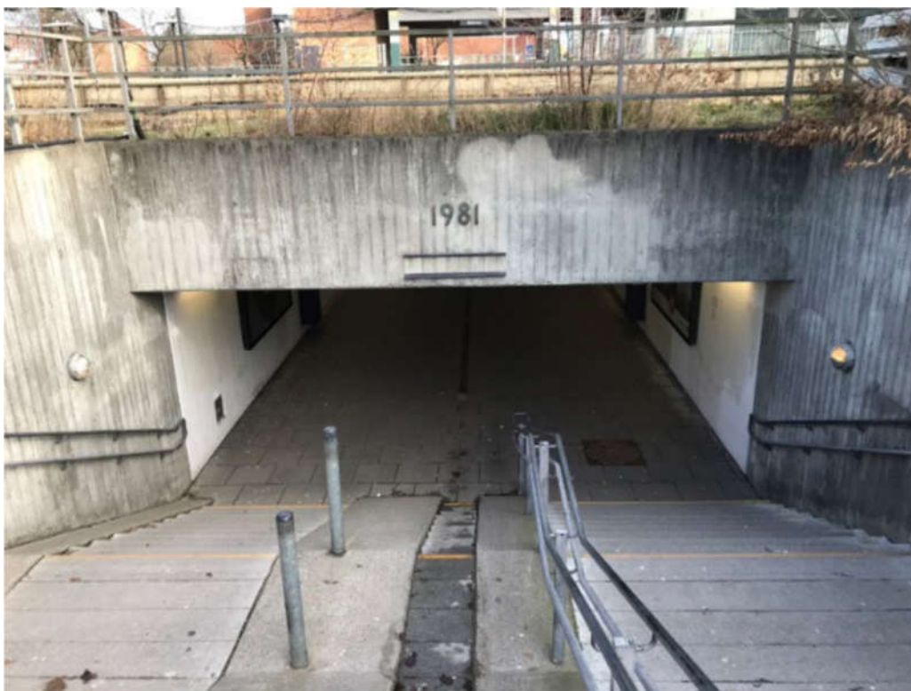
Figur A-9 – Sydlig trappenedgang i den vestlige perrontunnel (set mod nord)
