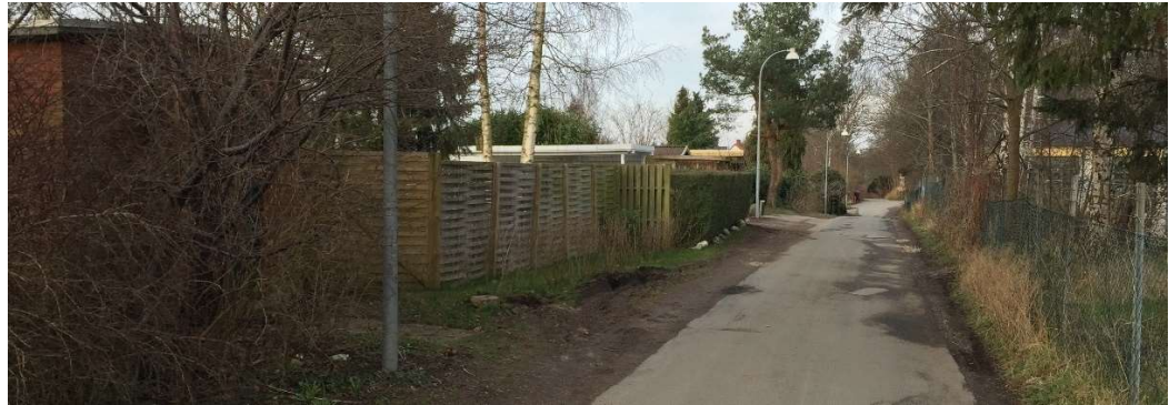
Foto 7: Potentiel vejlukning 2 ved transformestation mellem Tvendagervej 1A og 3.
