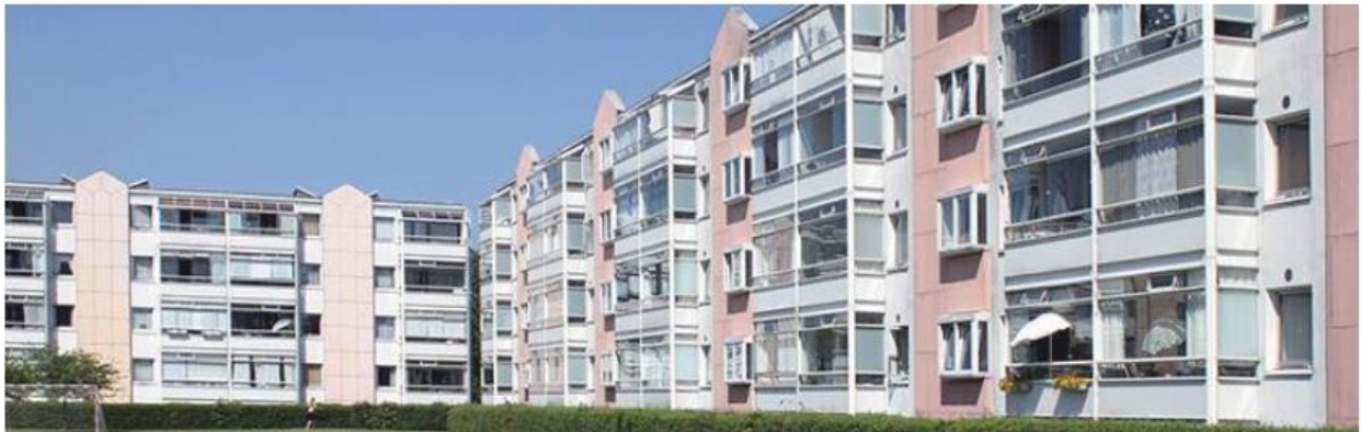
Ellebo som det så ud efter facaderenoveringen i 1991 med de tidstypiske pastelfarver.
