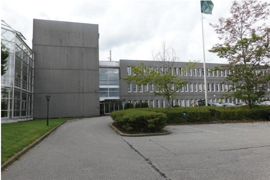
Den eksisterende kontorbygning.
