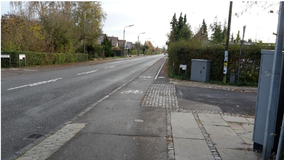
Figur 3: Ejbyvej ved Hasselvej set mod syd med overgang fra cykelsti/fortov til delte stier
