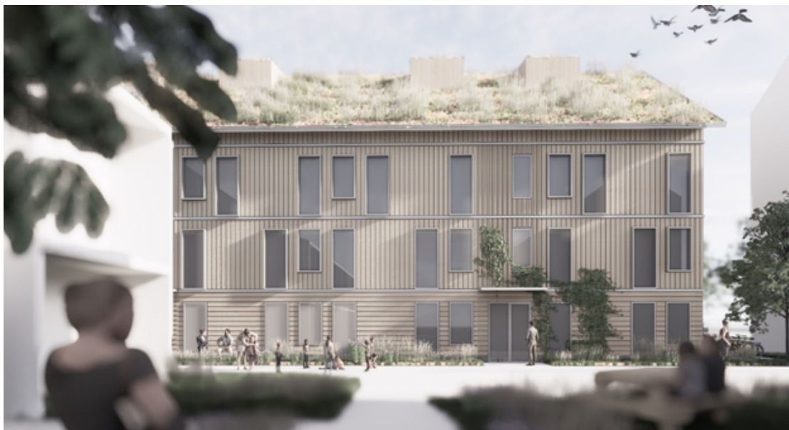
Facade 2. Eksempel på, hvordan træbeklædningen kan varieres. I stueplan ligger den på klink og skifter til lodret beklædning på de øvrige etager og for at markere overgangen. Derudover bliver hver etageskift markeret med en drypkant der også er med til at lede vandet væk fra.
