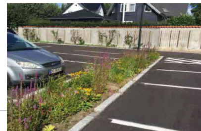
re etableres sænkede regnbede langs parkeringsrækker for at forsinke og nedsvive regnvand.
