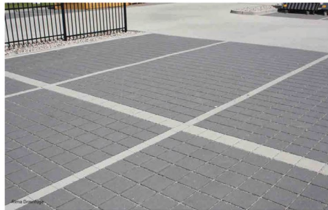
IBF SF-RIMA kan benyttes i IBF's Permadrain system som sikrer nedsvivning af regnvand. OBS: permeable opbygninger egner sig ikke til tung trafik.
