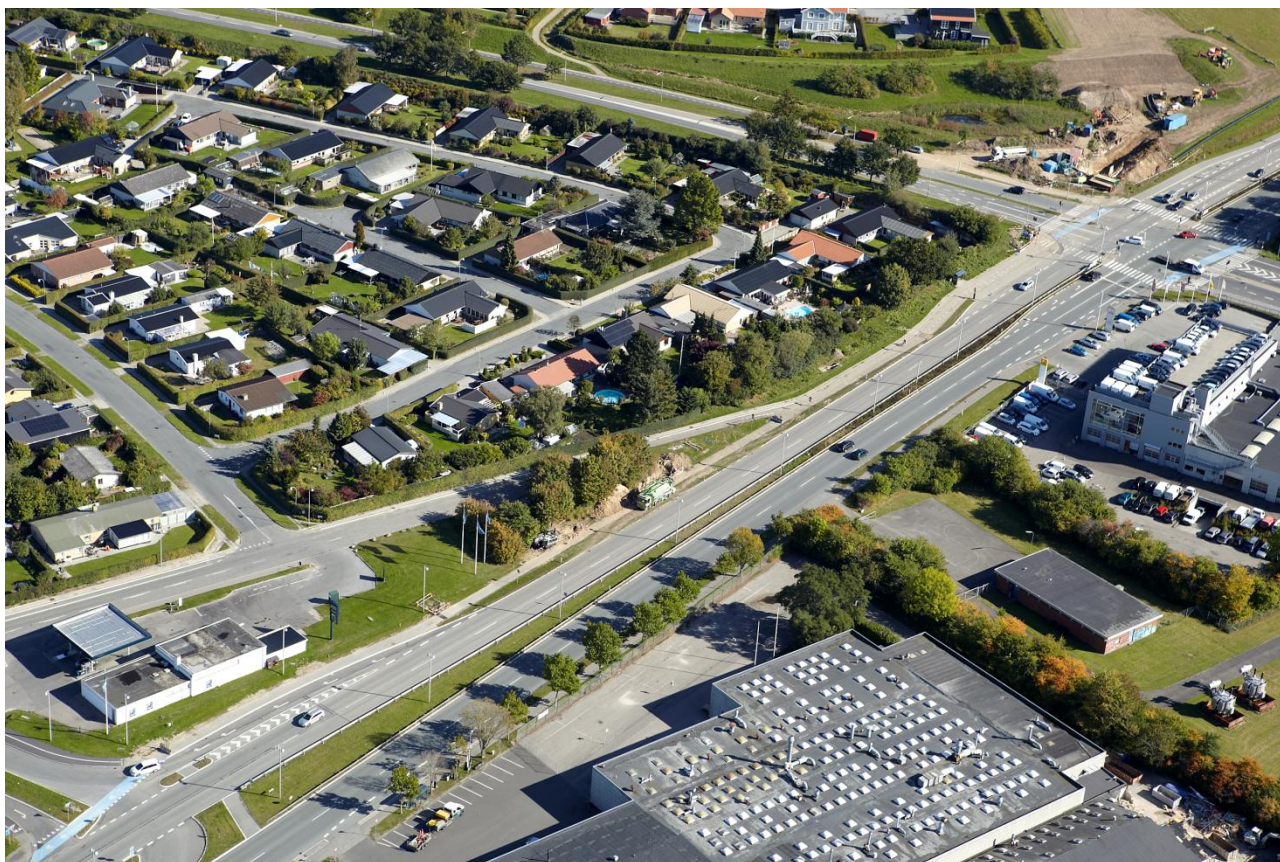
Lokalplanområdet set fra sydvest – under nedgravning af ny fjernvarmeledning.
