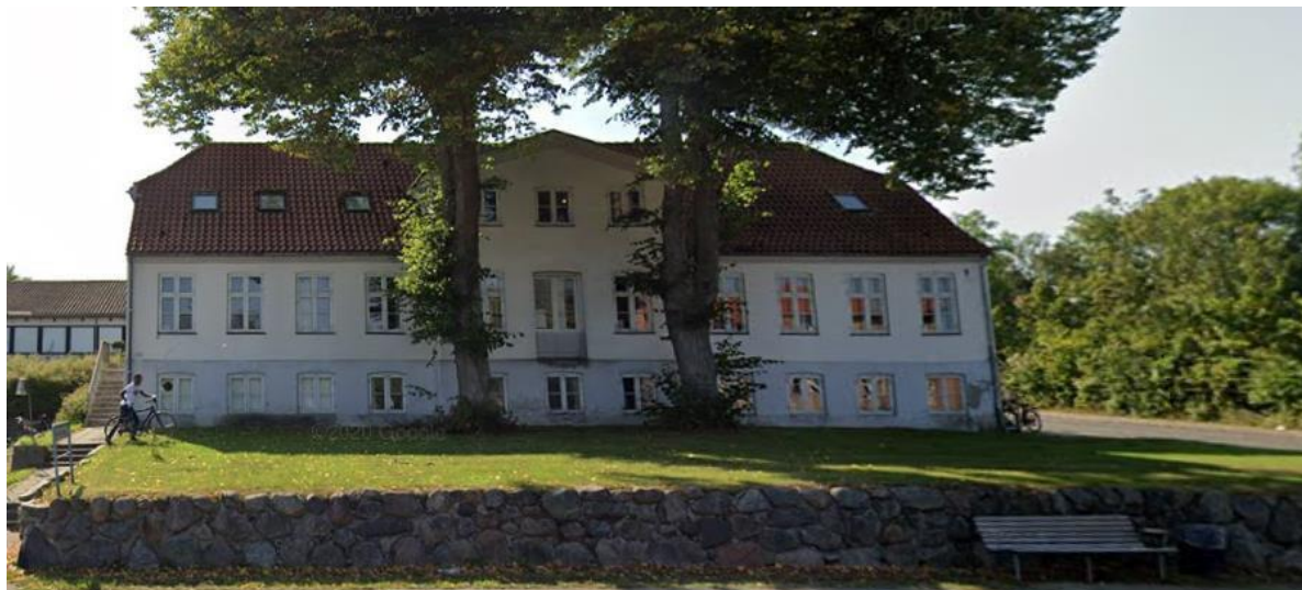
Illustration A: Møllens hovedbygning, nordfacaden i dag (foto 2021)
