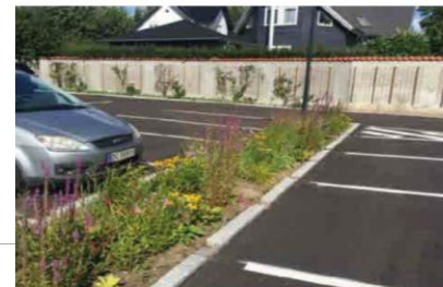
etableres sænkede regnbede langs parkeringsrækker for at forsinke og nedslive regnvand.
