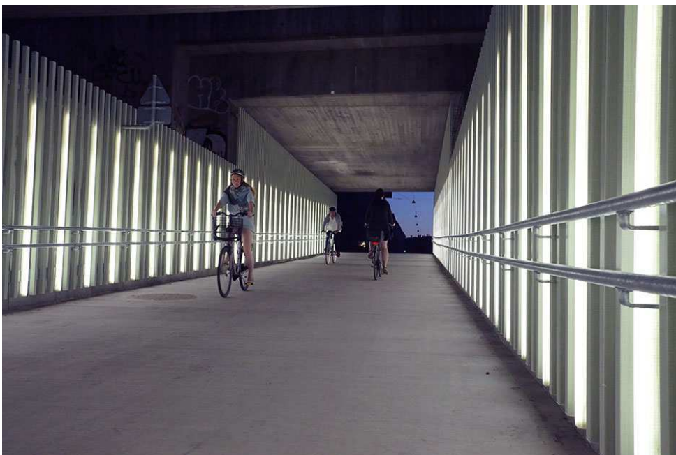
Figur 19 - Funktions- og effektbelysning i Nordhavnstunnelen, referencefoto
