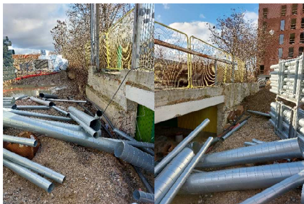
Figur 6- Eksisterende forhold - Fløjvægge
