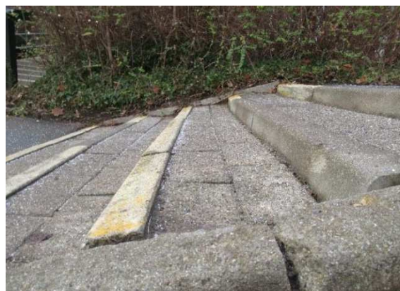
Figur 11 - Trappeanlæg syd for Ballerup Boulevard, hældning af rækværk og sætninger af kantsten
