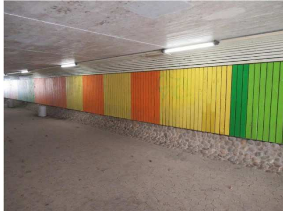
Figur 4 - Træbeklædning af vederlag
