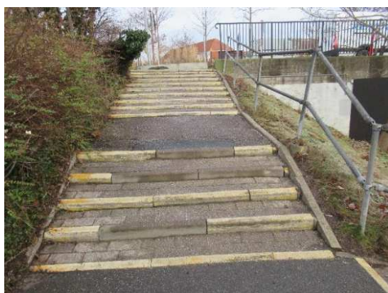
Figur 11 - Trappeanlæg syd for Ballerup Boulevard, hældning af rækværk og sætninger af kantsten
