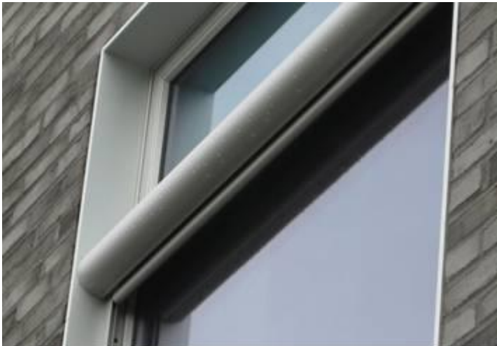
Figur 16: Princip for placering af udvendig mobil screen. Foto fra referenceprojekt VAT83.
