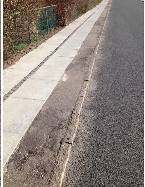
Fuldt renoveret fortov ekskl. forkant og kantsten
