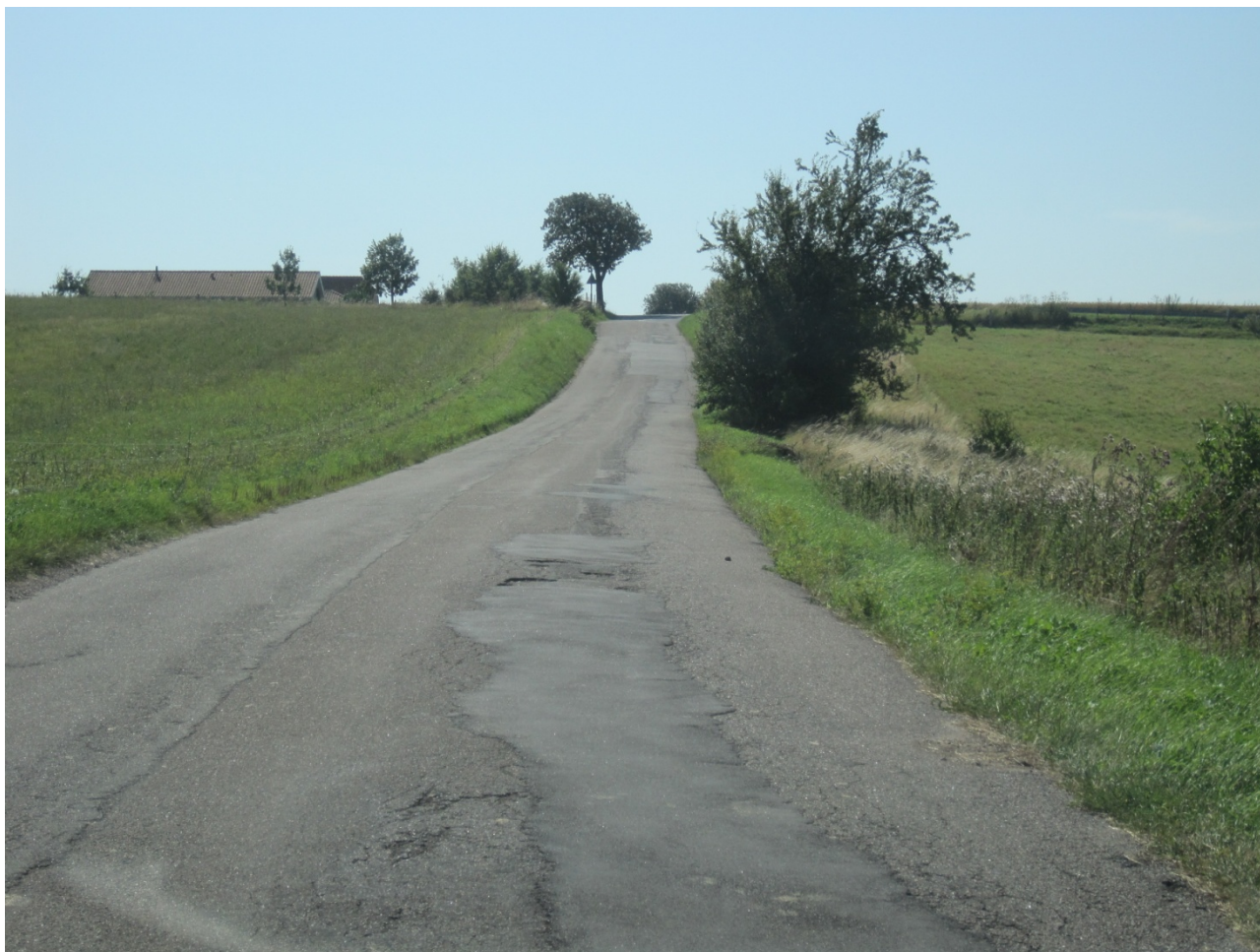
Den eksisterende Bringevej set mod syd
