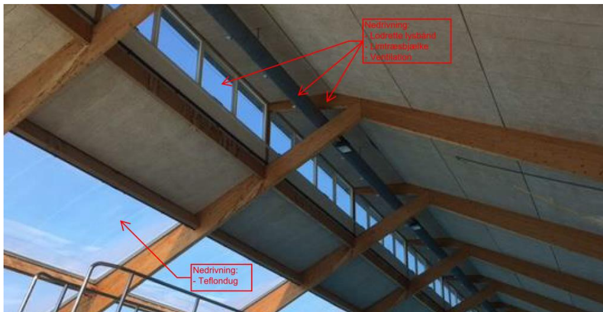
Foto af eksisterende bygningsdele som nedrives
